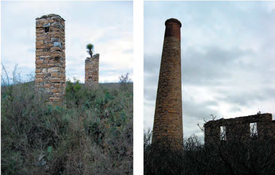
Figura 5. Imagen de los pilares para malacates movidos por animales y cuarto de bomba cornuallesa. Fotografías tomadas por el autor.
