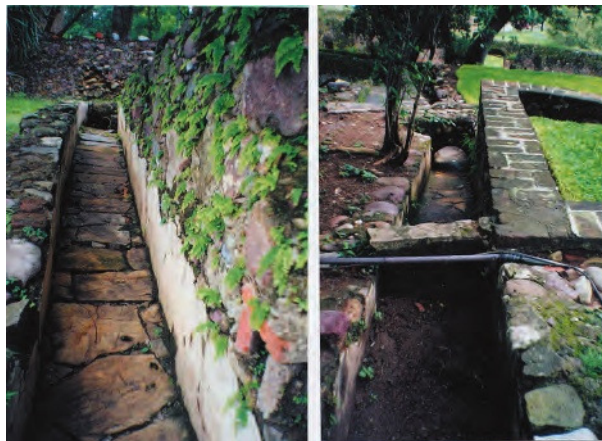
Figura 14. Canales abiertos. Muros laterales de roca tipo riolita, aplanados bruñidos, piso de laja tepetate y protección de ladrillo de barro.
