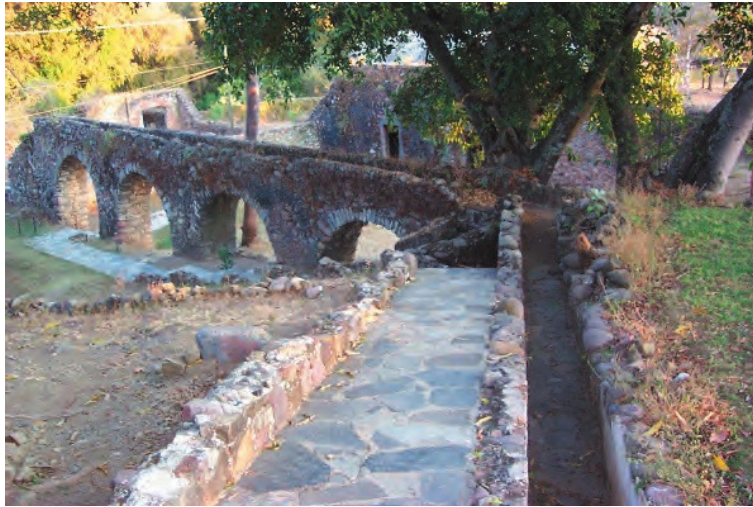
Figura 13. Canales abiertos a acueducto menor en zona 4. a sección. Al fondo la bóveda de guardado y molienda n.º 4.
