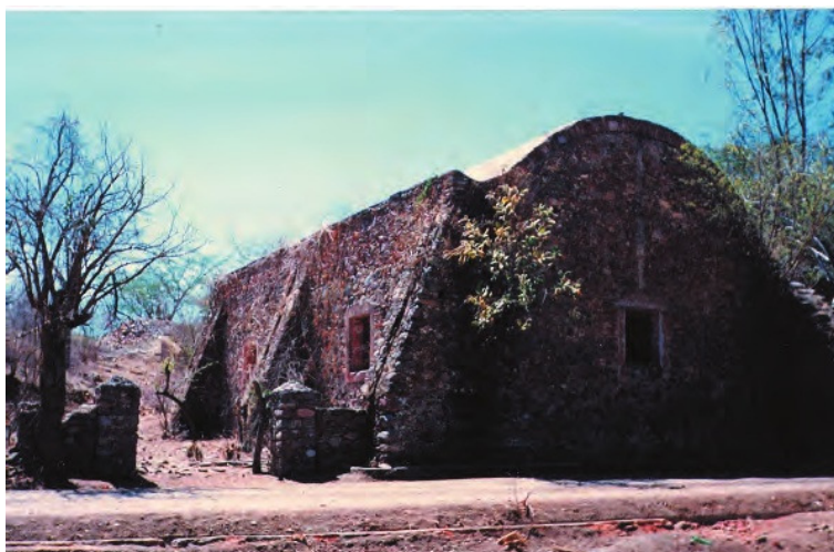
Figura 15. Bóveda de cañón. Contrafuertes sólo en el lado sur.
