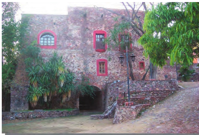
Figura 18. Vista frontal al oriente de la Casa Principal. La fachada estuvo aplanada tipo “calavereado”. La fábrica es una constante en toda la construcción.
