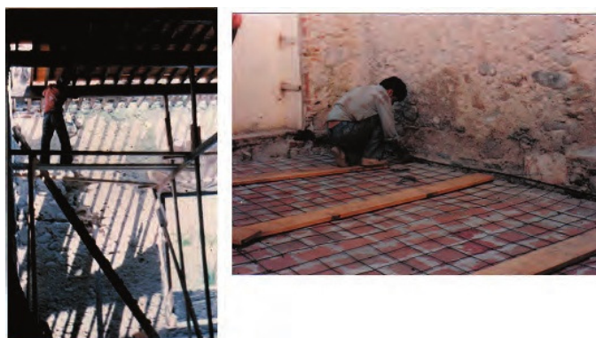
Figura 19. En 1985 se intervino proponiendo a la bóveda catalana malla electrosoldada y refuerzo de acero 3/8" con concreto armado.
