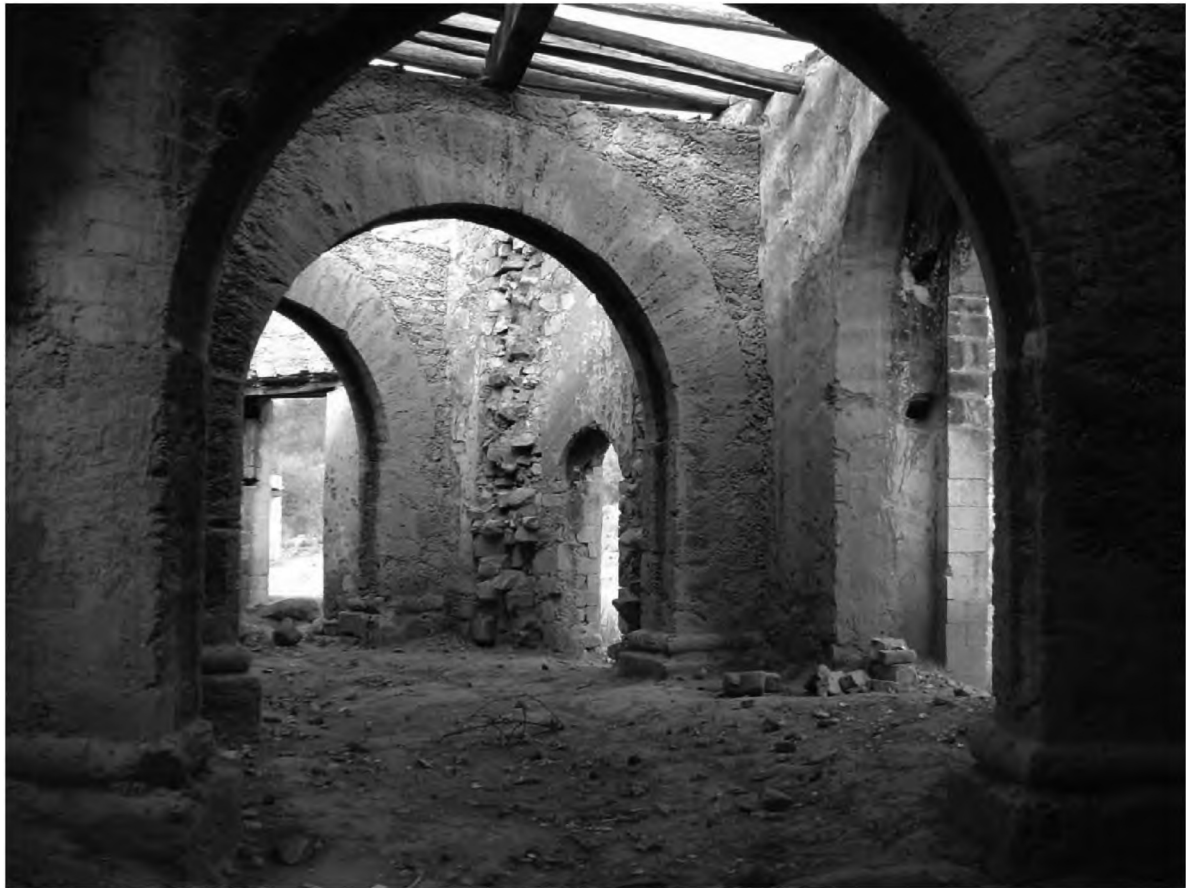
Fig. 5. Vista interior del andén. Fotografía del autor (2011)
