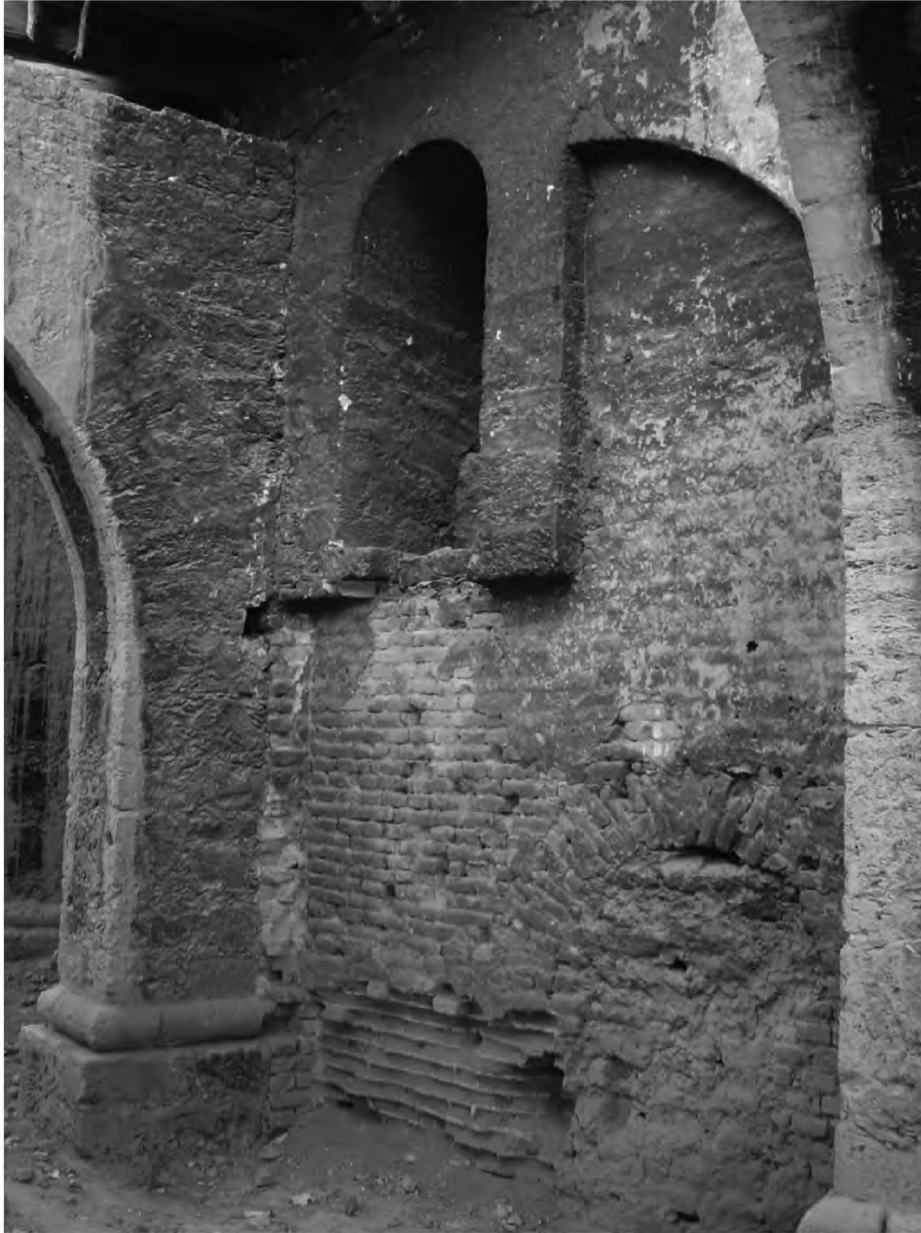
Fig. 7. Frontis del horno, desde el interior del andén. Fotografía del autor (2011)
