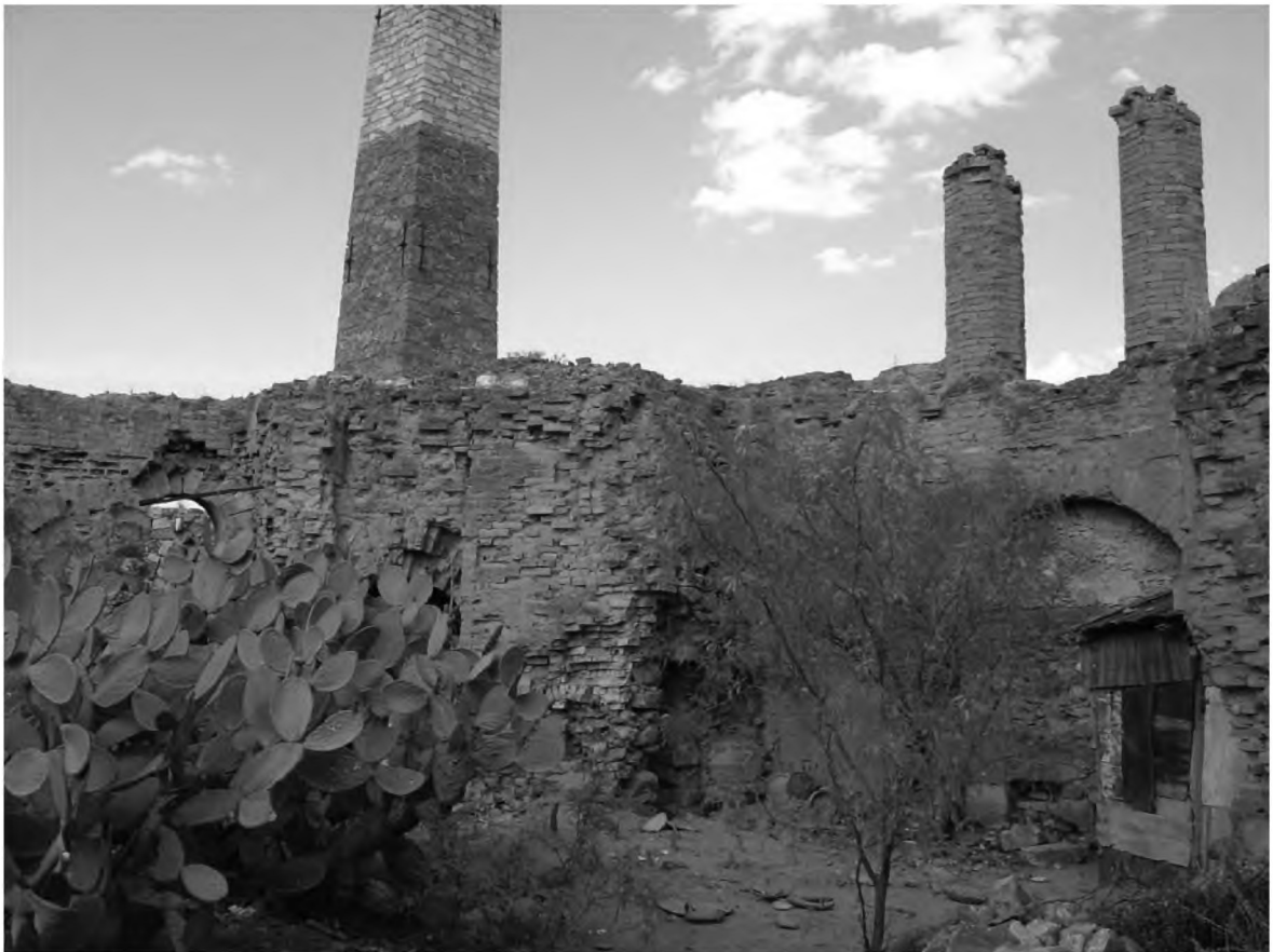
Fig. 6. Vista interior donde debieron ubicarse los hogares. Fotografía del autor (2011)
