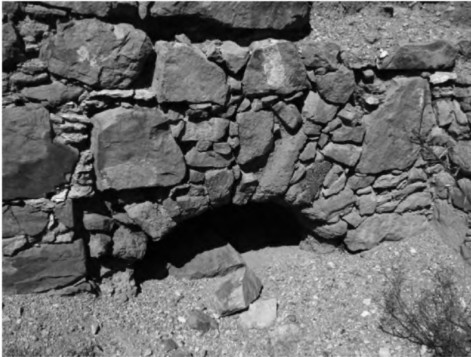
Fig. 13. Detalle de puerta de fuego. Fotografía del autor (2011)
