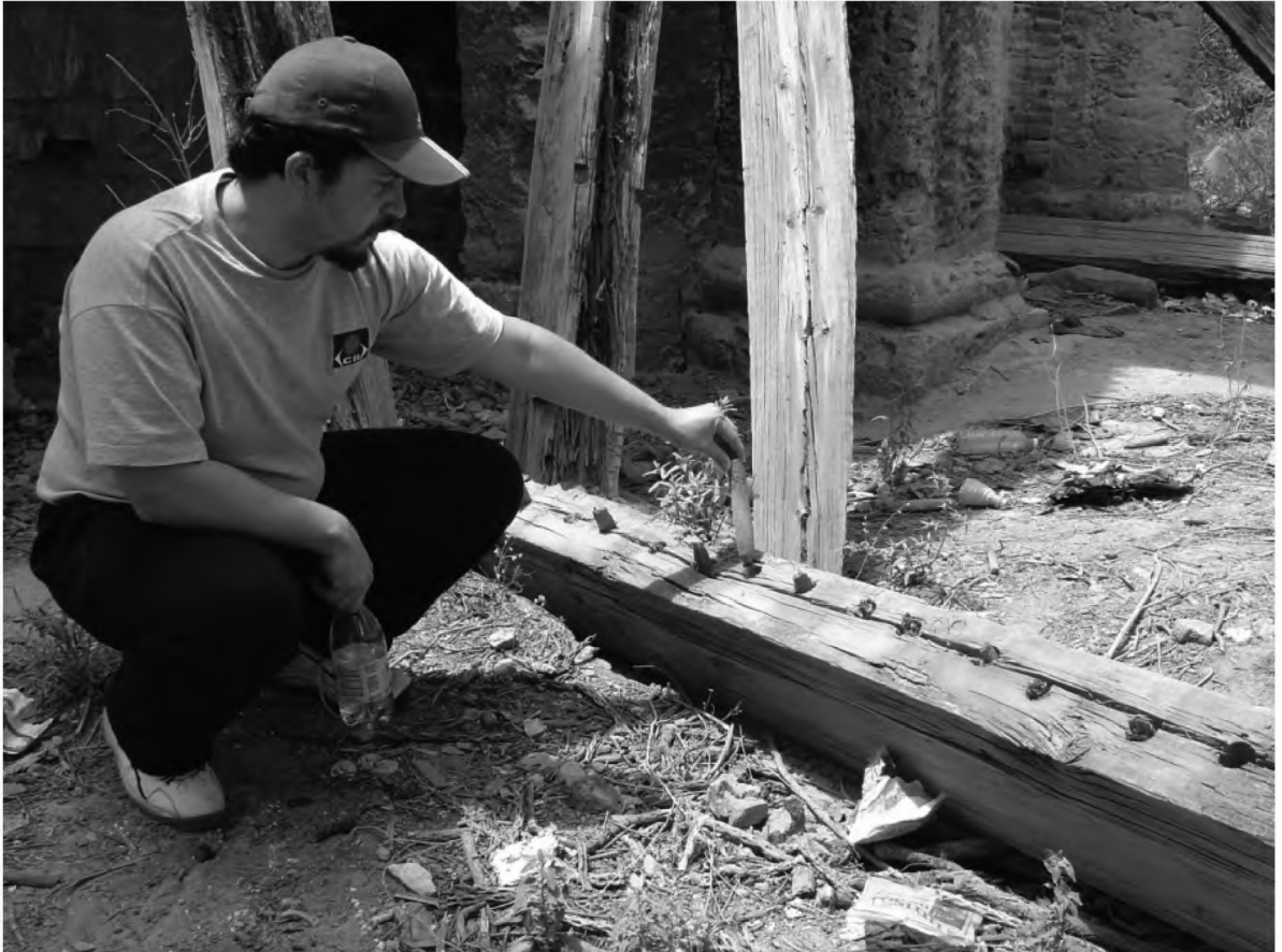
Fig. 8. Aspecto del detalle de los pernos de sujeción del andén superior. Fotografía del autor (2011).
