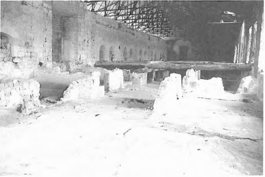
Fig. 1. Interior del dormitorio.
