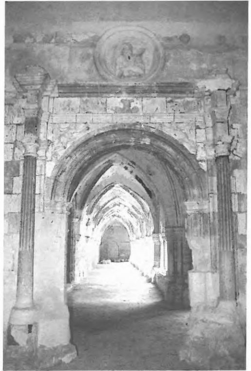
Fig. 8. Puerta de comunicación del claustro con el vestíbulo. Vista desde el vestíbulo.
