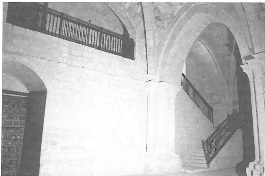
Fig. 3. Iglesia. Escalera de acceso al claustro alto.
