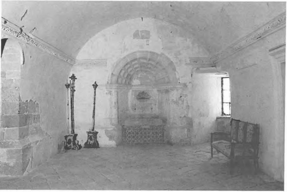
Fig. 6. Sacristía. Interior hacia el este.
