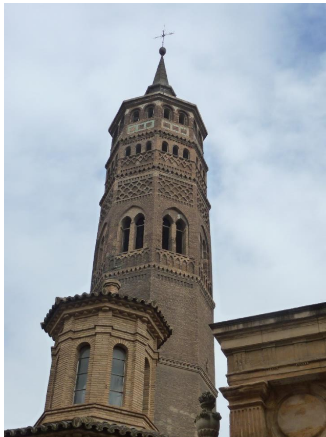
Imagen 1: Torre campanario de la iglesia de San Pablo en Zaragoza
