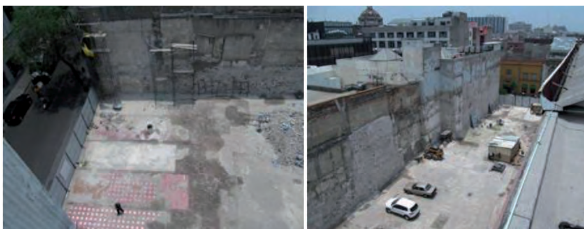
Fig. 6. Vistas del predio antes de iniciar las excavaciones. (Informe del proyecto de excavación de salvamento arqueológico de República de Uruguay n°54 y Venustiano Carranza n°53. México 2013)
