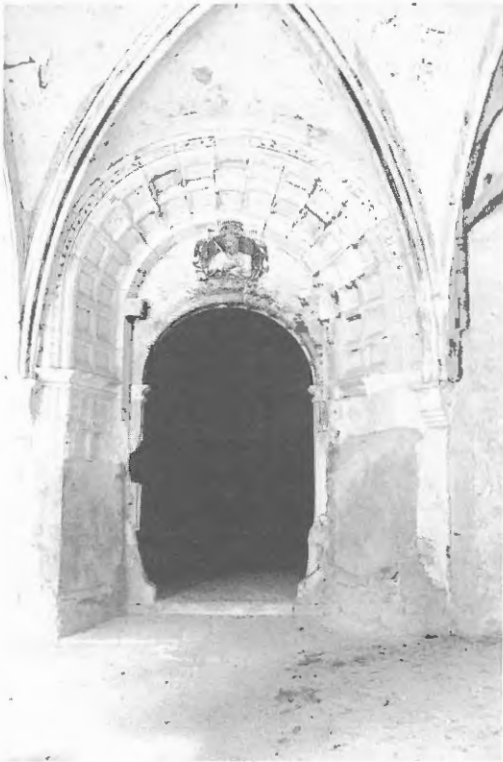
Fig. 7. Puerta de comunicación del claustro con el vestíbulo. Vista desde el claustro.
