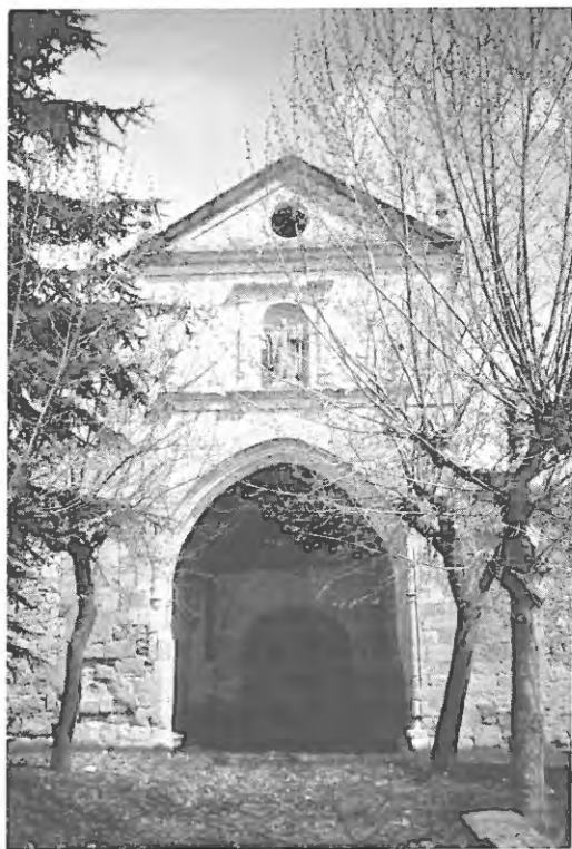
Fig. 16. Portería, desde el exterior.
