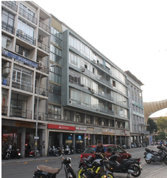
Figura 5. Edificio de oficinas y locales comerciales en calle Imagen. Fuente: Elaboración propia
