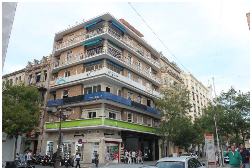
Figura 3. Edificio de viviendas en Laraña. Fuente: Elaboración propia
