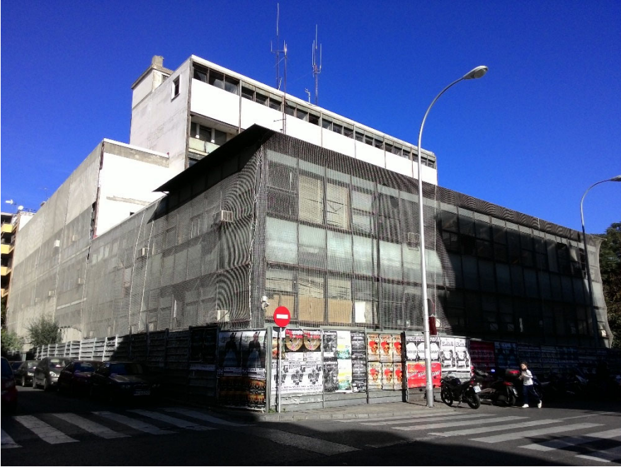
Figura 2. Edificio de la antigua comisaría de la Gavidia. Fuente: Elaboración propia
