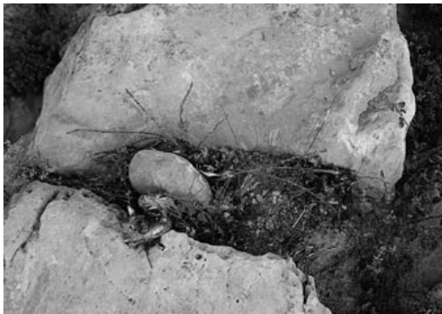
FIG. 9. Detalle de pequeñas piedras sirviendo de ripios en el calzado de varios sillares de la zona actual de coronamiento del muro (Foto: J. Armendáriz).
