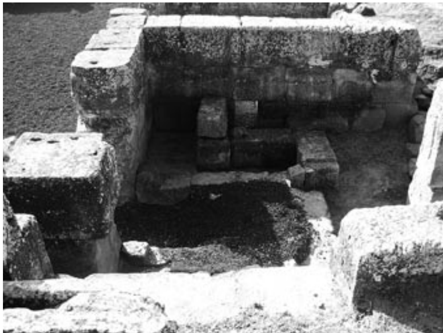
FIG. 7. Detalle del propnigeum en su extremo noreste donde se hallan situados los prae furnia que alimentaron de calor los alvei del caldarium . (Fotos: V. García-Entero).
