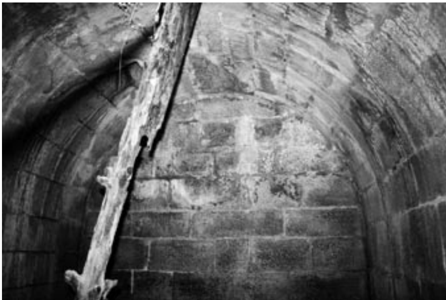
FIG. 10. Detalle del paramento interior de la cisterna ubicada al Este de la Ermita de Nuestra Señora de Los Bañales (Foto: F. Castillo).
