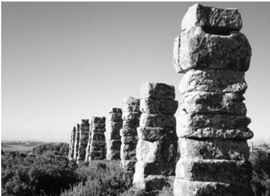
FIG. 7. Primera pilastra del Tramo I descrito por A. Beltrán en el acueducto, con la caja para el specus cubierta por un bloque, seguramente en posición secundaria (Foto: S. González Soutelo).
