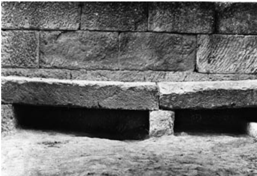
FIG. 18. Bancos del lado Norte de la estancia G (sala de espera) con detalle de la labra de los mismos por medio de «surcos inclinados» (Foto: A. Beltrán).
