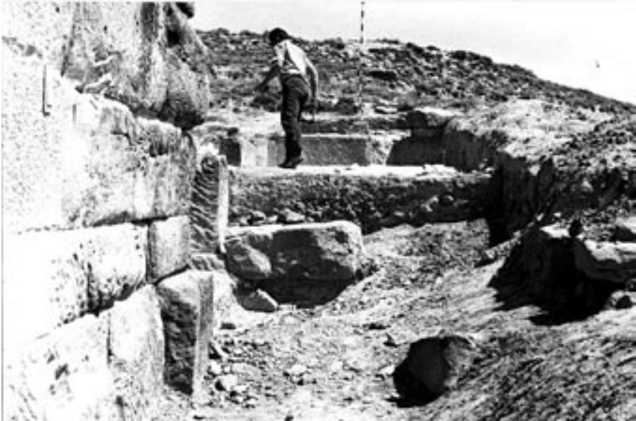
FIG. 21. La «zona L» antes de su limpieza y excavación. Al fondo, el «espacio K», de vestíbulo (Foto: A. Beltrán).
