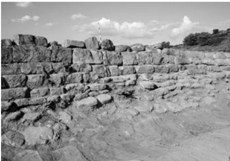
FIG. 7. Paramento central en el que se observan, nítidamente, las dos fábricas diferentes de la construcción (Foto: J. J. Bienes).
