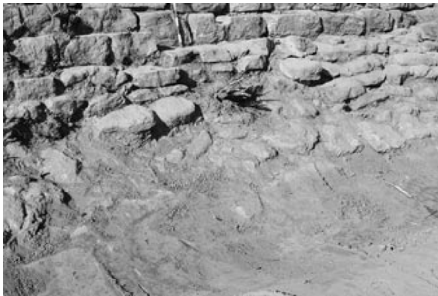
FIG. 11. Detalle de la parte central de la pantalla de la presa, con las primeras hiladas apoyadas directamente, sobre el terreno arcilloso (Foto: J. J. Bienes).
