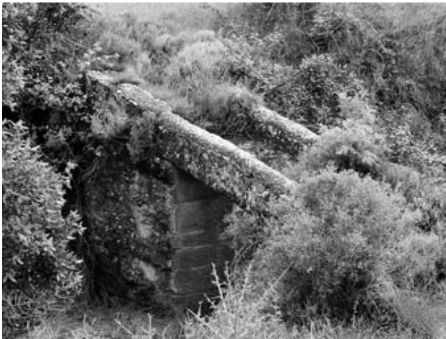
FIG. 2. Puente al servicio de alguna antigua acequia de la zona, en la margen derecha del río Arba, tal vez aludida como romano por J. Galiay (Foto: Á. A. Jordán).
