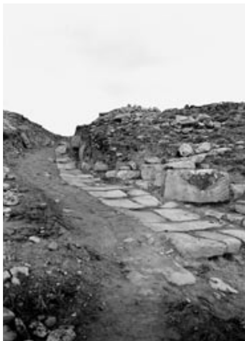
FIG. 21. Instantánea de 1943 de la vía de subida al cerro de El Pueyo de Los Bañales donde J. Galiay creyó encontrar la cimentación del arco descrito por J. B. Labaña (Foto: J. Galiay, Archivo Histórico Provincial de Zaragoza, Ref.: ES/AHPZ – GALIAY 001460, © Gobierno de Aragón).
