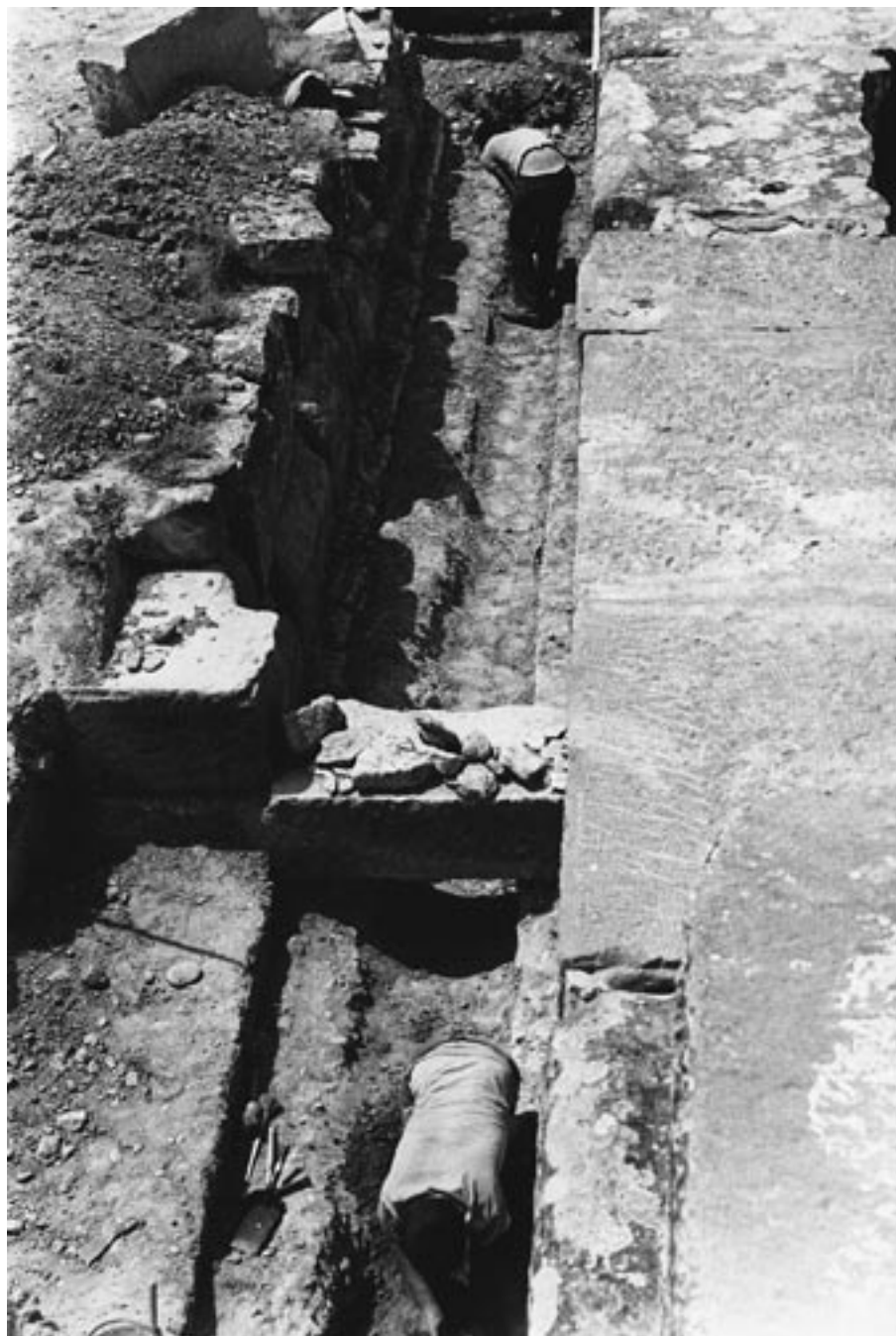
FIG. 25. Trabajos de limpieza del espacio de letrinas de las termas en la campaña del verano de 1973, de A. Beltrán (Foto: A. Beltrán).
