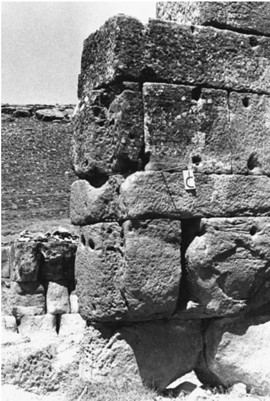
FIG. 16. Puerta de comunicación del espacio C2 ( tepidarium ) con el B ( caldarium ) con detalle de rebaje en los tres primeros sillares para encaje del vástago y del marco de la puerta de madera y de los orificios para la fijación de las tegulae mammatae (Foto: Á. Beltrán).
