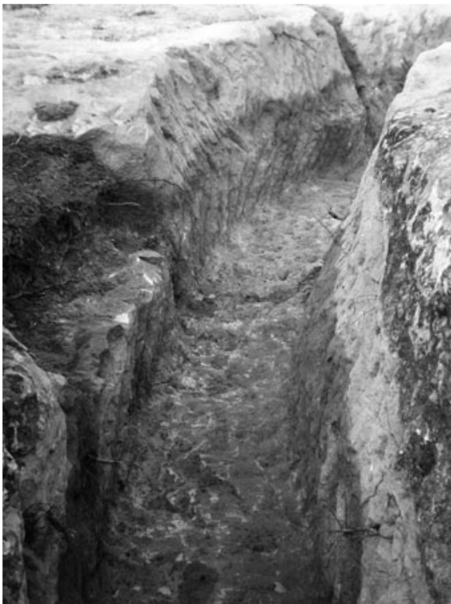
FIG. 15. Último tramo de specus del sistema hidráulico de la ciudad romana de Los Bañales, antes de su llegada al espacio urbano (Foto: J. Andreu).
