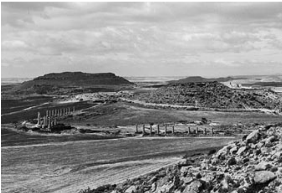
FIG. 1. Vista general acueducto.
