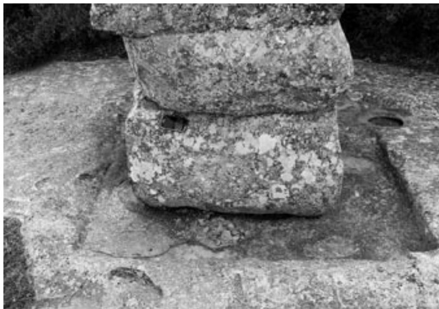
FIG. 5. Detalle de la cimentación de los pilares sobre el afloramiento rocoso.
