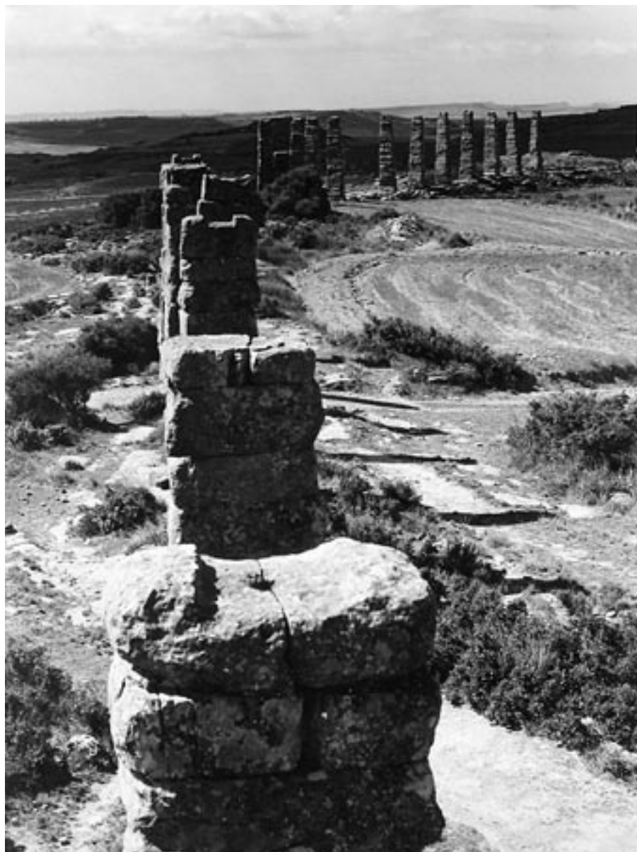
FIG. 2. Detalle de la perforación vertical en el sillar de coronación.
