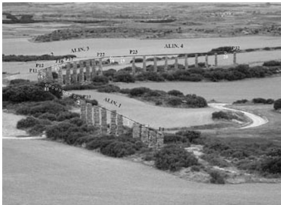
FIG. 7. Vista general en alzado desde Puy Foradado con identificación de alineaciones y pilares entre P1 y P32.
