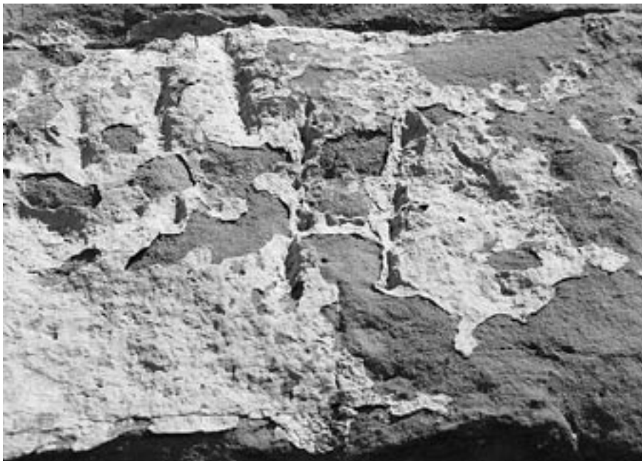
FIG. 8. Marca "H" sobre uno de los pilares del Tramo I descrito por A. Beltrán, totalmente cubierta por la calcificación (Foto: P. Faus).
