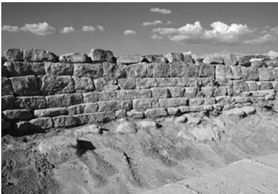
FIG. 8. Parte Oeste del muro de la presa donde puede apreciarse la somera labra de algunos de los sillares con los que ésta fue construida (Foto: J. J. Bienes).
