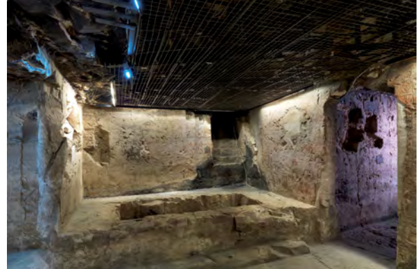
Figura 9. Estado final de la capilla de Djehuty. En esta imagen se puede observar el falso techo de hierro y las luces led ya montadas.
