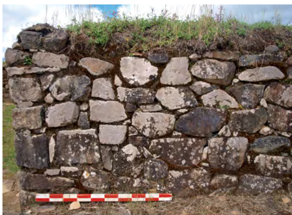
Figura 13. Biocolonización irreversible de las estructuras murarias por líquenes crustáceos.
