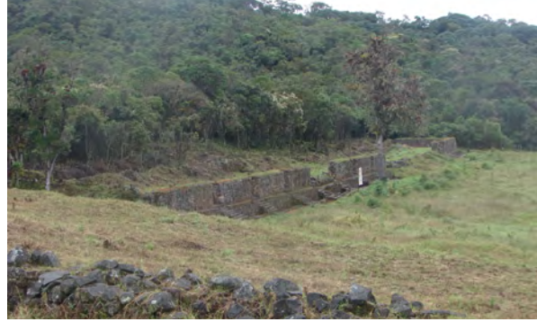
Figura 8. Vista panorámica de la kallanca desde el acllahuasi . Se trata de una de las estructuras de mayor dimensión de este tipo documentadas hasta el momento.
