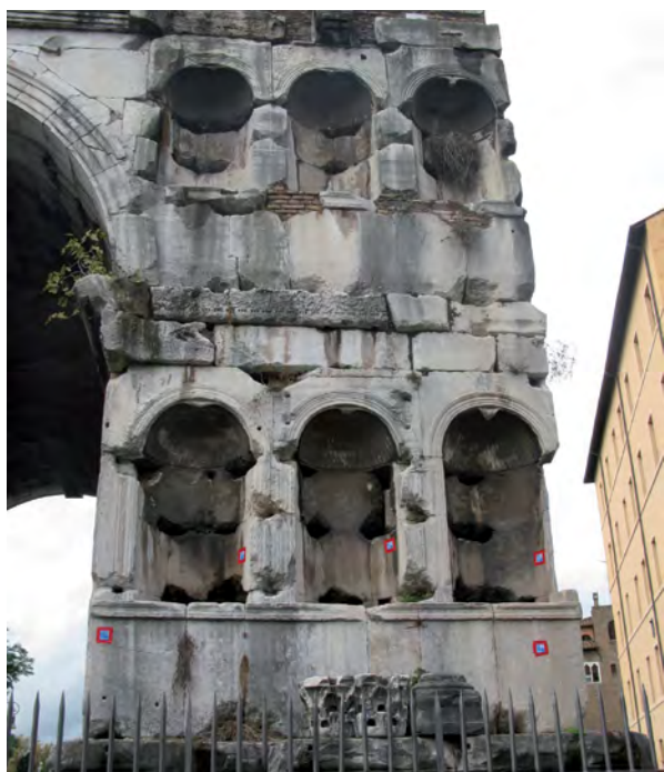
Figura 2. Vista de detalle del pilar noroccidental del arco.
