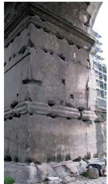
Figura 5. Detalle de los huecos para la colocación de vigas en época medieval.
