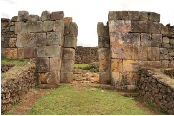
Figura 5. Vista general de la portada de acceso al acclahuasi , con aparejo tipo imperial a base de grandes bloques paralelepípedos.
