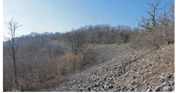
Figura 12. Panorámica del gran bastión que da soporte al canal de evacuación curvado de la zona de Bunda di Canej.
