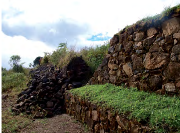
Figura 12. Sector 13F, estructura muraria donde la actividad restauradora quedó interrumpida. Se puede observar la metodología de trabajo y la presencia de trincheras y pilcas.
