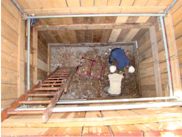
Figura 5. Vista cenital del inicio de la excavación. Retirada de las cajas con material amorfo depositado en 2011.
