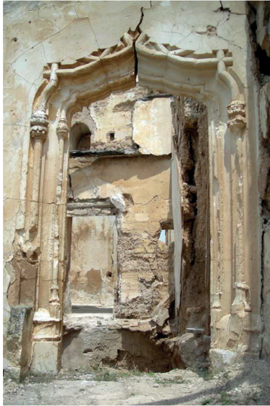
Figura 11. Puerta gótica de yeso de la escalera del patio del palacio de Bolbaite (Valencia) (RMS).
