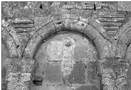
Figura 38. Fachada oriental del ábside. Elemento n.º 24.
