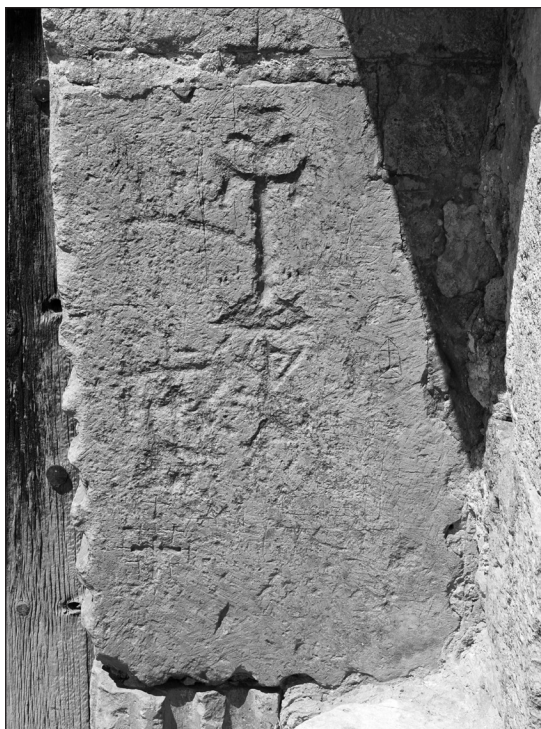
Figura 29. Jamba derecha. Elemento nº 15. Vista de la sección.
