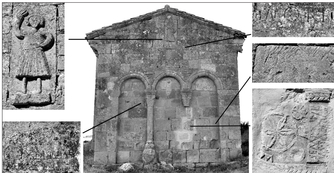
Figura 11. Fachada oriental del ábside, que presenta empotradas algunas inscripciones romanas, un relieve medieval anterior a la construcción de la ermita y, a la derecha de la imagen central, una inscripción seguramente moderna.
