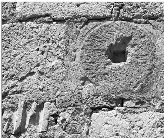
Figura 31. Fachada meridional. Elemento n.º 17.
