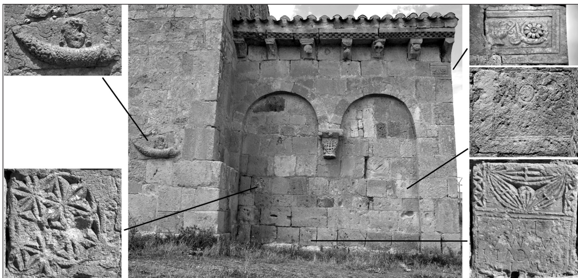
Figura 10. Fachada meridional del ábside, en su estado actual, con indicación de las piezas de época romana que están empotradas.
