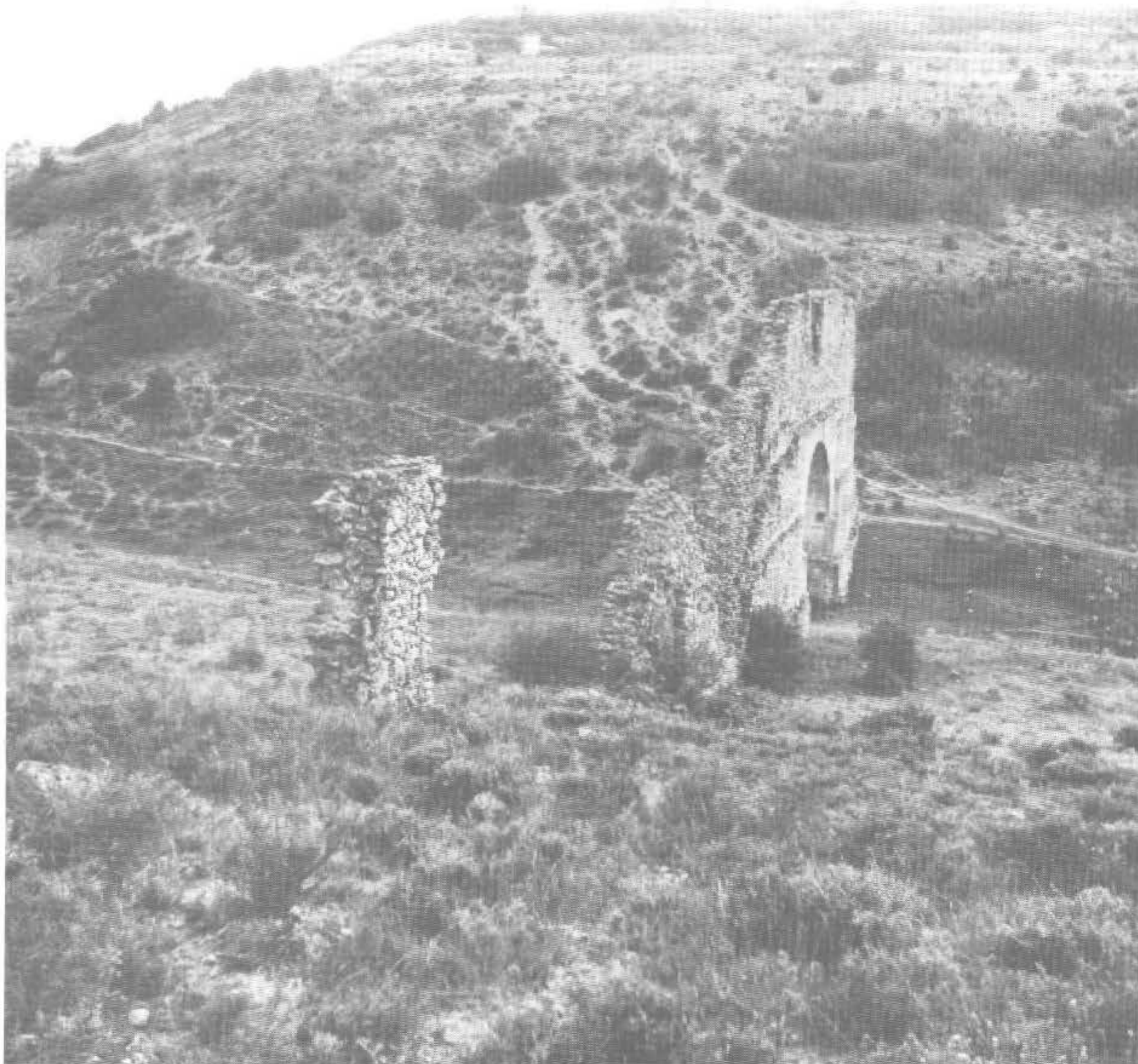
Lámina I - Vista general, fachada Norte. Valoramos su fábrica escalonada, magnitud del arco y hornacina superior. Al fondo, en la cima de la ladera observamos aún una caseta de captación de agua.
