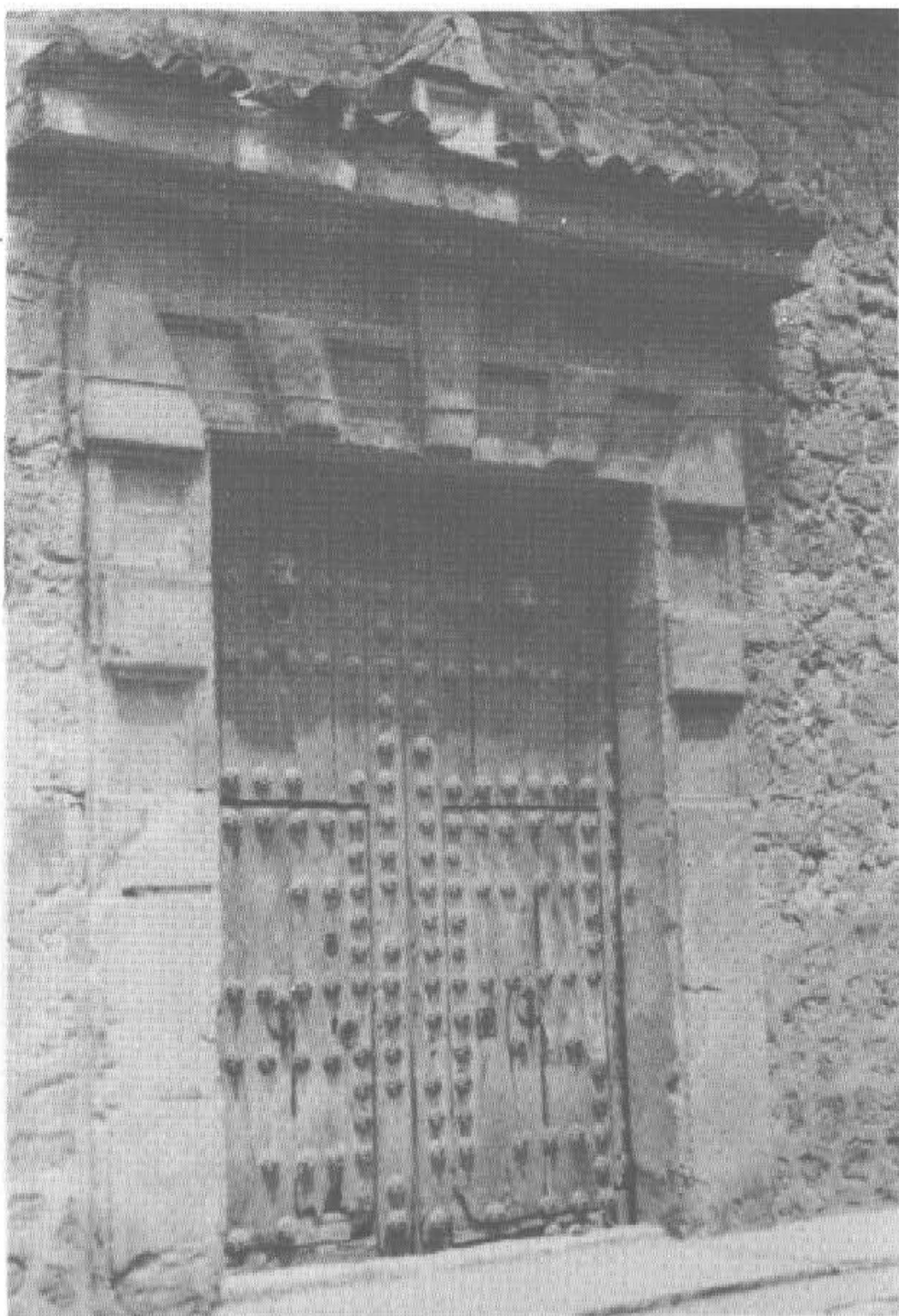
Foto 5.- CENTENERA (Guadalajara).-Puerta de la Iglesia
