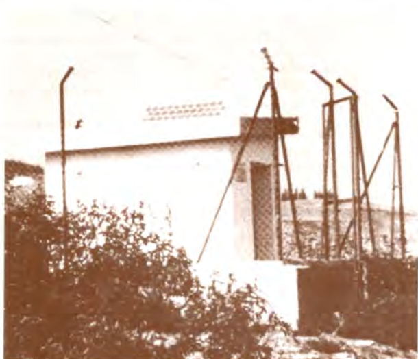
Estación sísmica automática de Vianos (Albacete). (Fotografía Servicio Sismológico).
