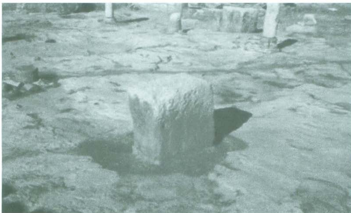
Lám. V. 2. Pilar realizado probablemente ex novo para la construcción de la iglesia. Está calzado con cal en el interior de una cubeta excavada en la roca.
