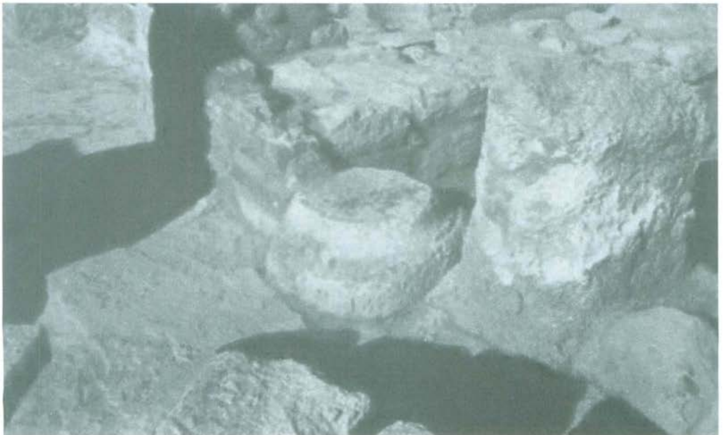
Lám. IV. 2. Basa toscana de columna reemplada en la arquería sur de la iglesia.
