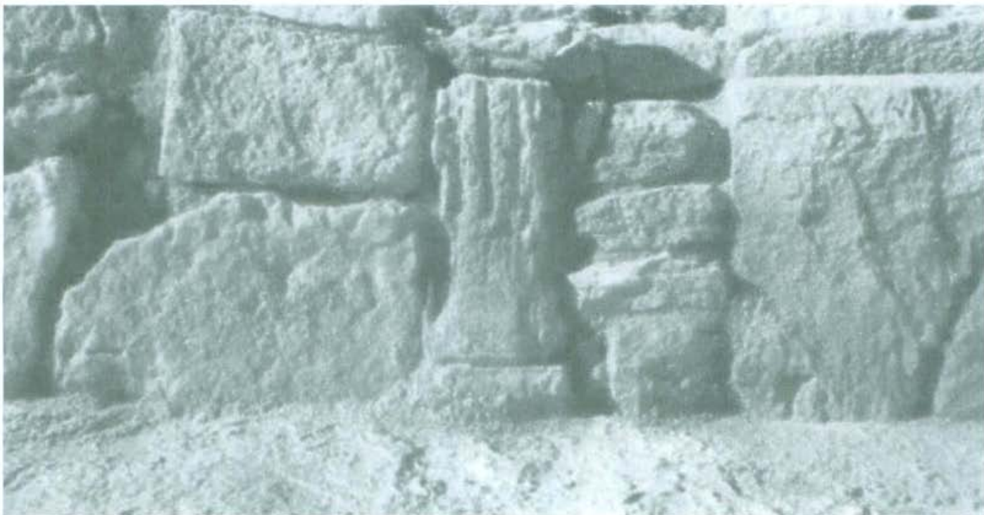
Lám. I. 1. Basa ática y fuste estriado de pilastra reempleados en un muro de la iglesia visigoda.
