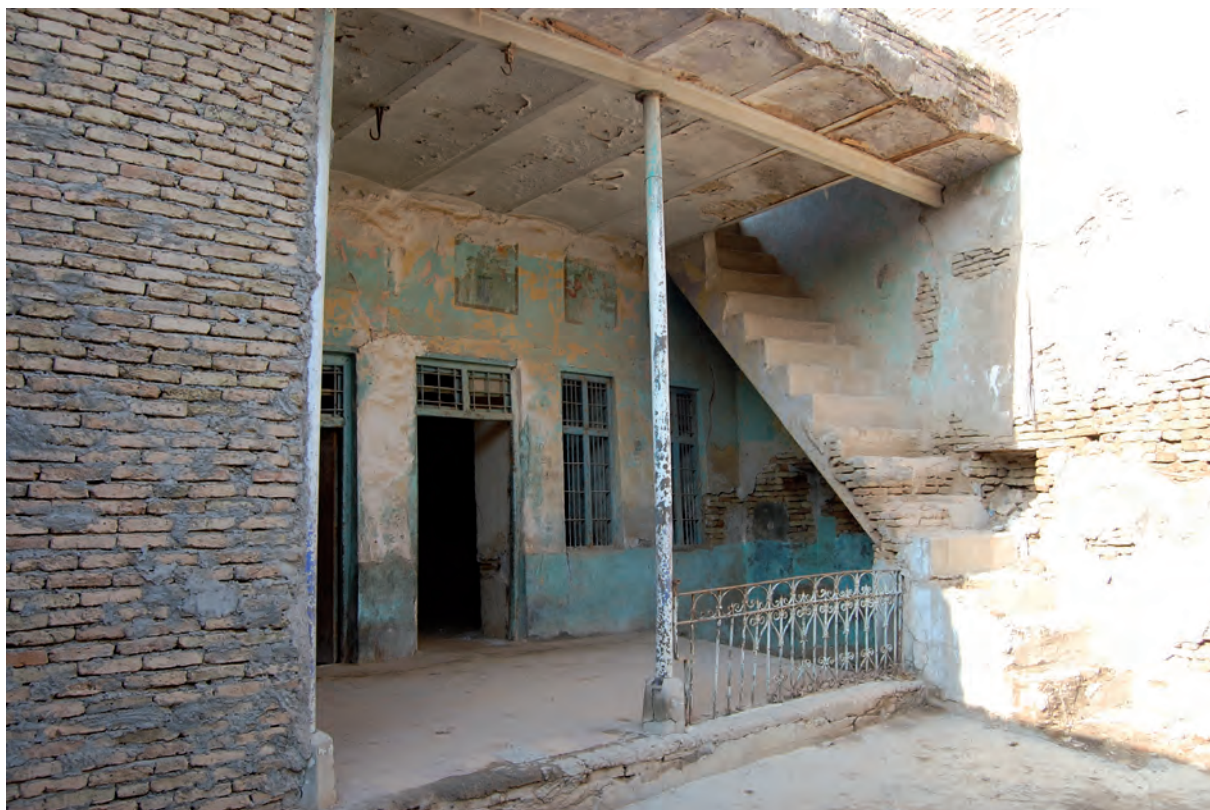
Figura 4: Patio de la casa 10/8. Fotografía: Alberto Garín.
