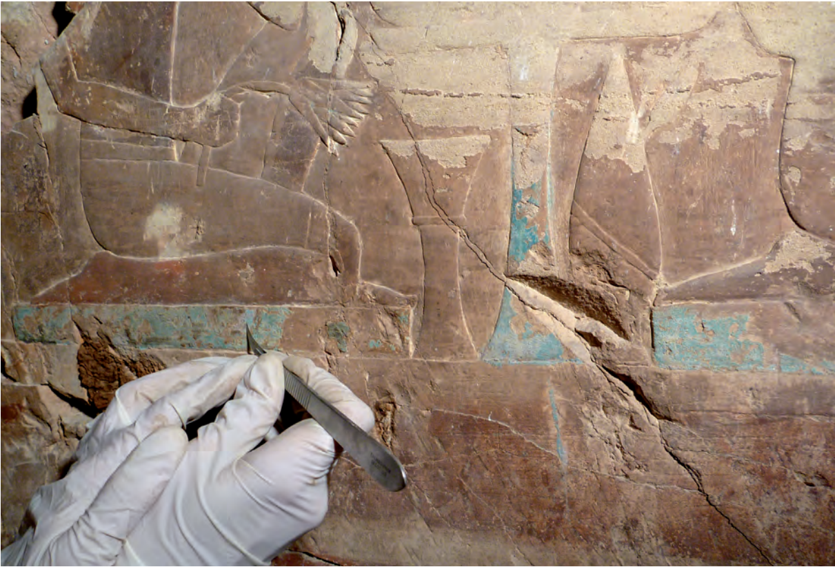
Figura 2: Limpieza y consolidación de las paredes de la sala transversal de la tumba-capilla de Djehuty.
