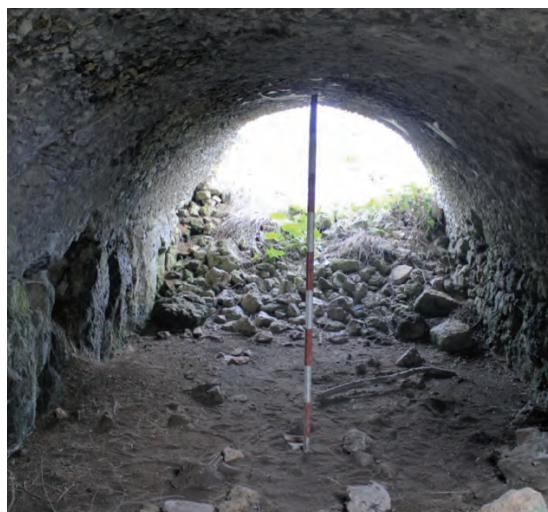
Figura 6: Vista interior del criptopórtico.
