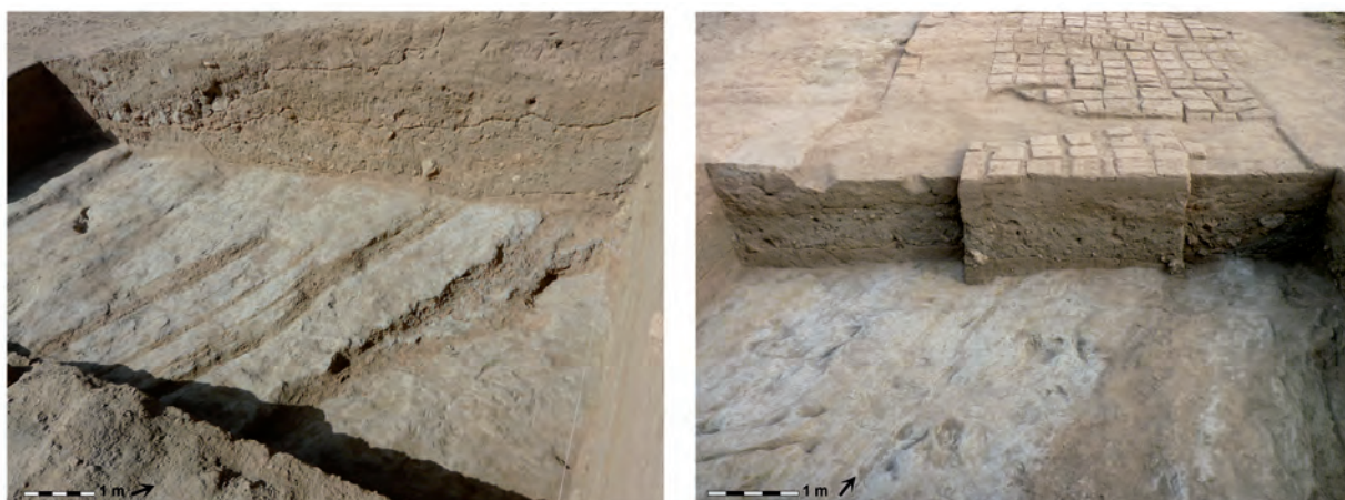
Figura 7 (izquierda): Tchinguz Tepe, Termez. Sustrato recortado, en RB2. Figura 8 (derecha): Tchinguz Tepe, Termez. Sustrato recortado, niveles de preparación y primeras hiladas de adobes correspondientes a la cimentación de la muralla en RB3.
