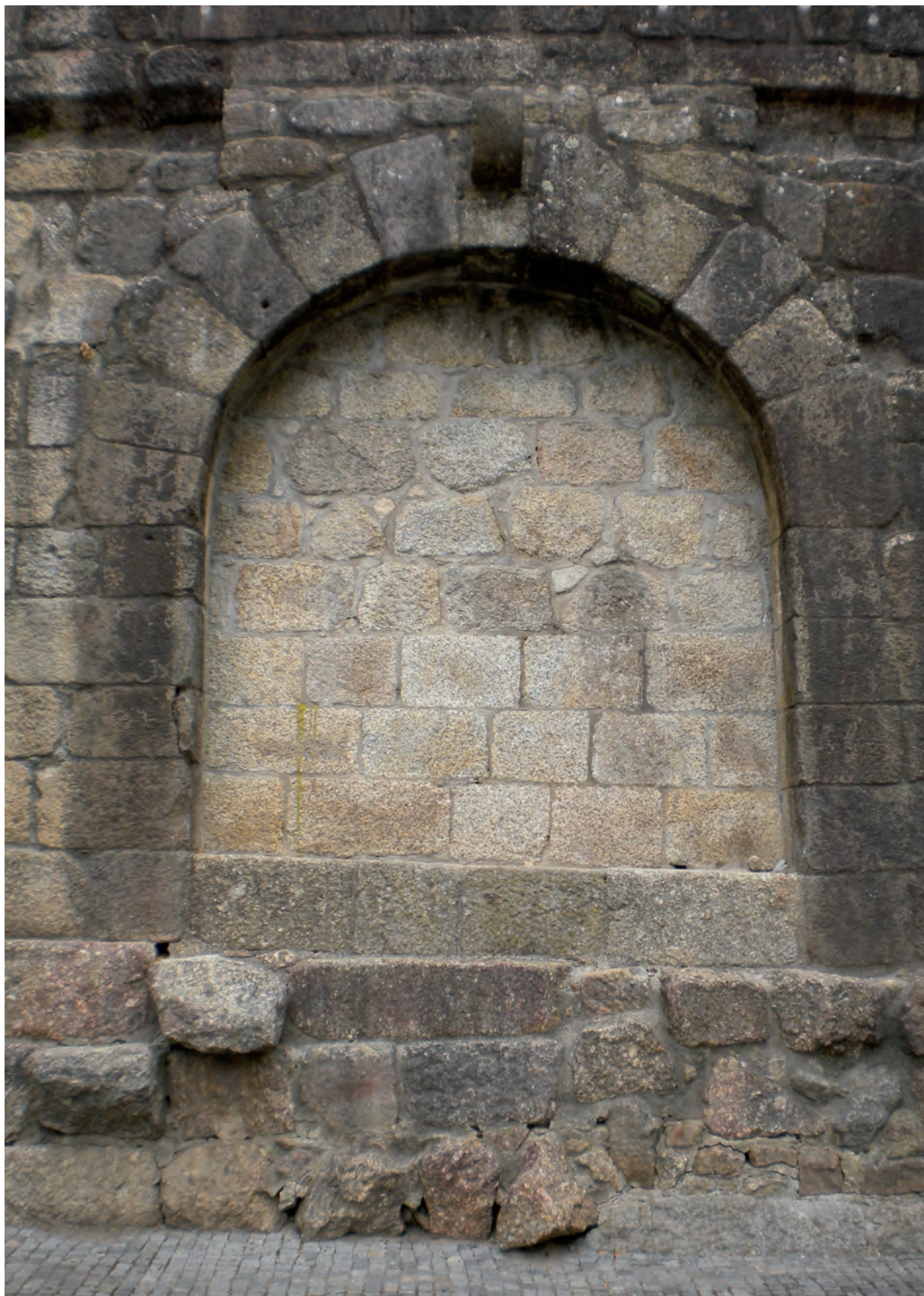
Figura 8: Arco de la mitad occidental del lienzo meridional (UE 1009) y tramo central de la rosca modificado (UE 110). Fotografía: M.ª Á. Utrero Agudo.
