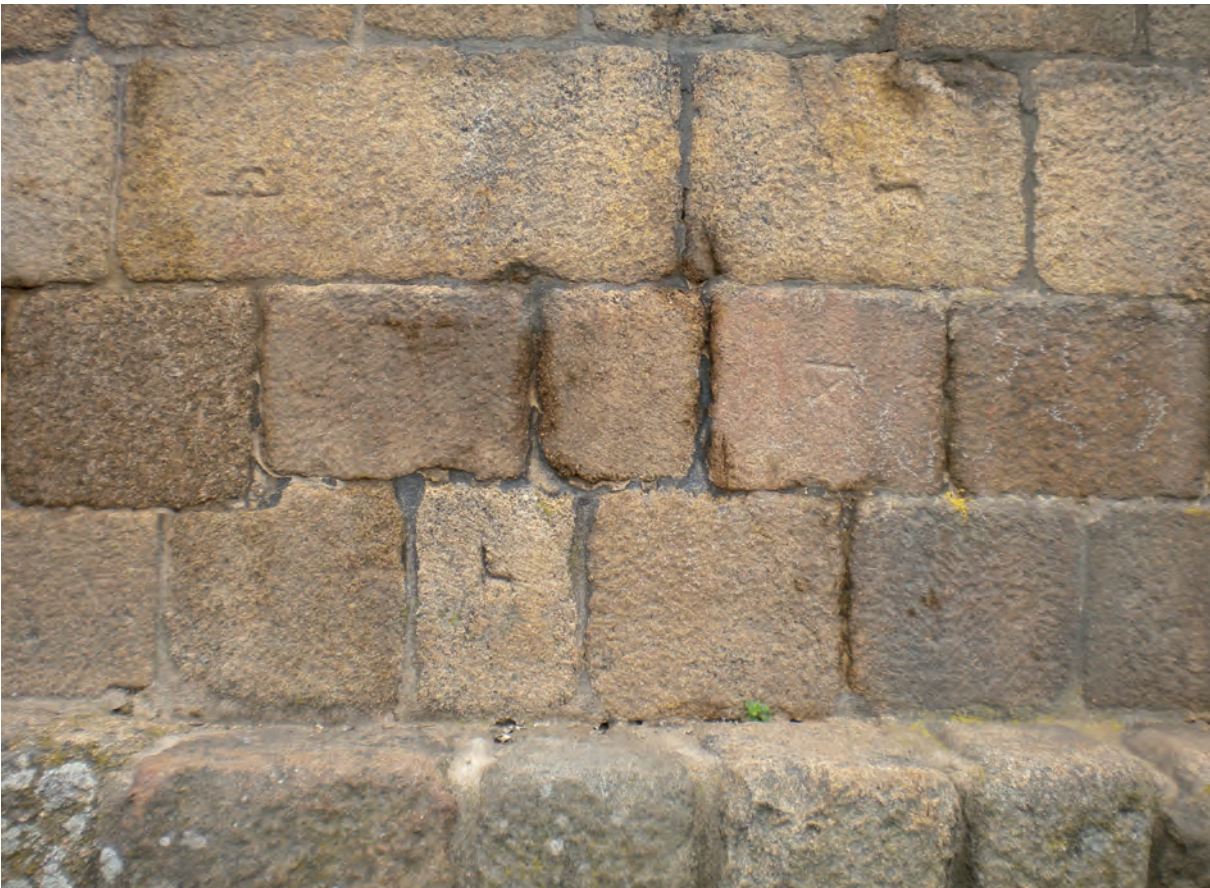
Figura 12: Detalle de las marcas de cantero en la fachada oriental de la fábrica UE 1009. Fotografía: M.º Á. Utrero Agudo.
