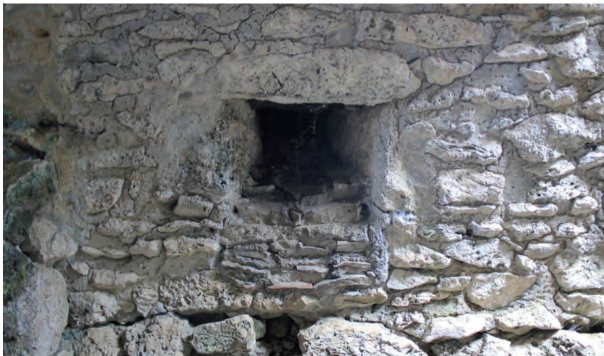
Figura 7: Detalle de una de las ventanas que abrían a la calle 5.
