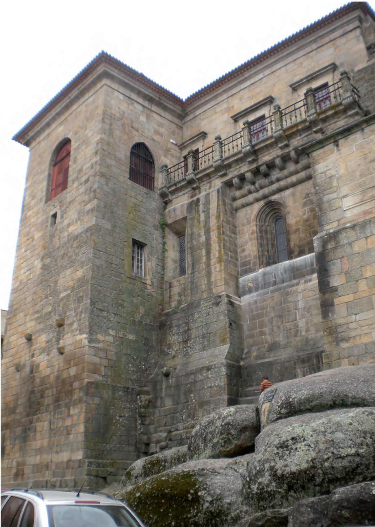
Figura 13: Vista general de la torre sureste desde el NE, con la parte inferior (UE 1009) y superior (UE 1012), y la capilla del Espírito Santo (UE 1029) entre ella y el transepto. Fotografía: M.º Á. Utrero Agudo.
