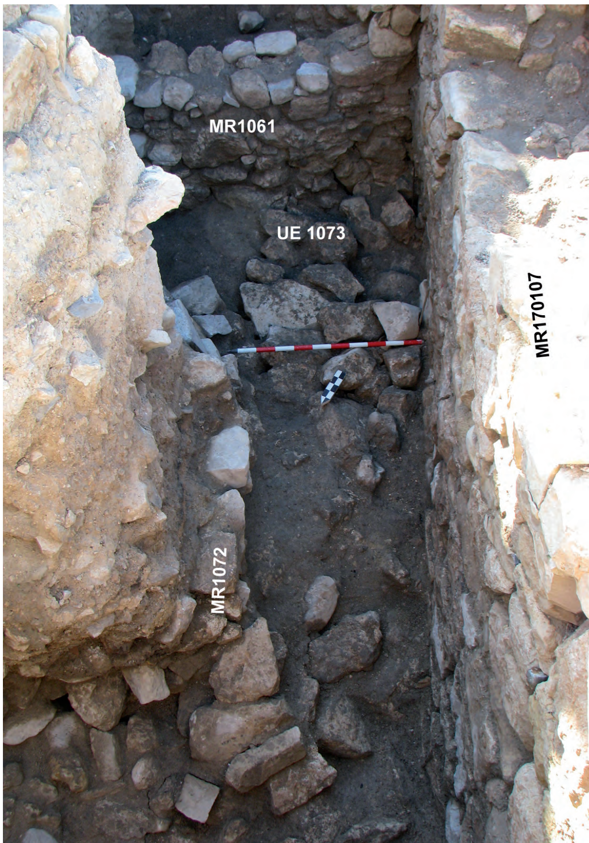
Figura 3: Vista de la muralla MR170107, el muro MR1061 y el muro MR1072 a nivel de la UE 1073.
