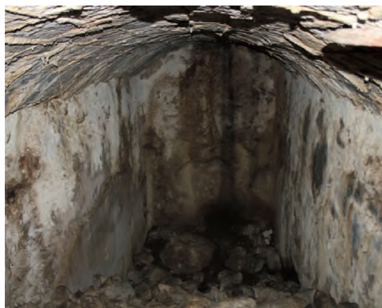
Figura 4: Vista del interior de la cisterna (DP1092).
