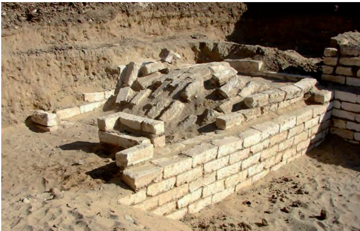
Figura 10: Derrumbe de techo de Tumba 34.
