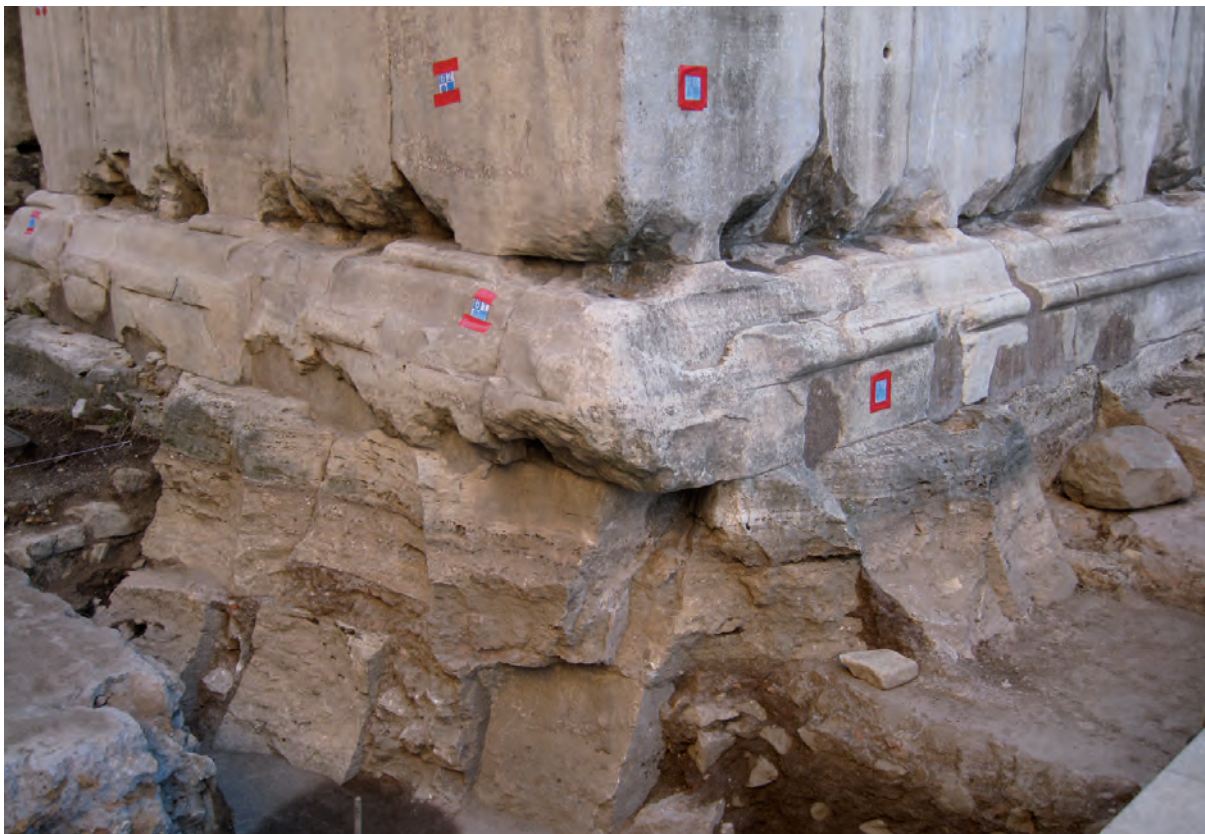
Figura 9: Vista de detalle de la cimentación de la jamba noroeste del arco de Giano.
