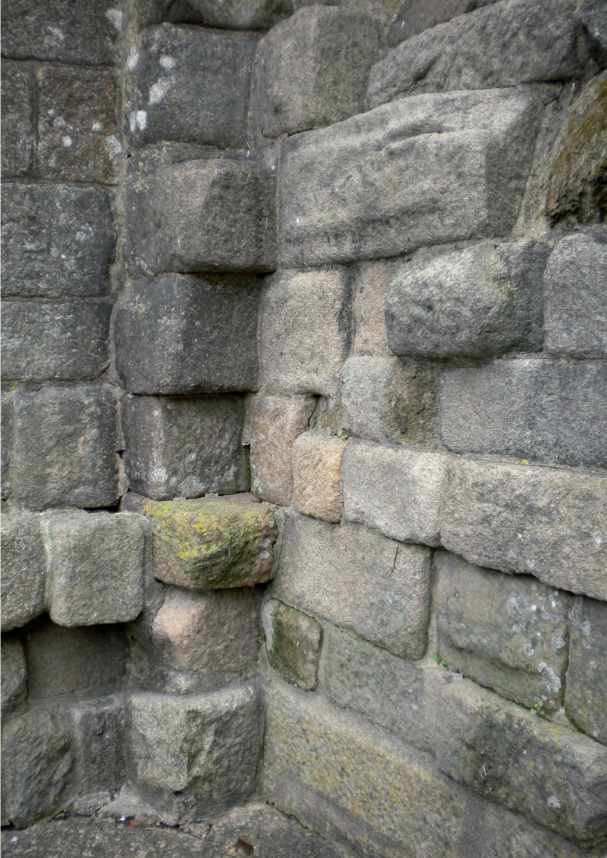
Figura 6: Estructura en el lienzo oriental (UE 1025 y 1026) de sillería almohadillada reutilizada. Fotografía: M.º Á. Utrero Agudo.
