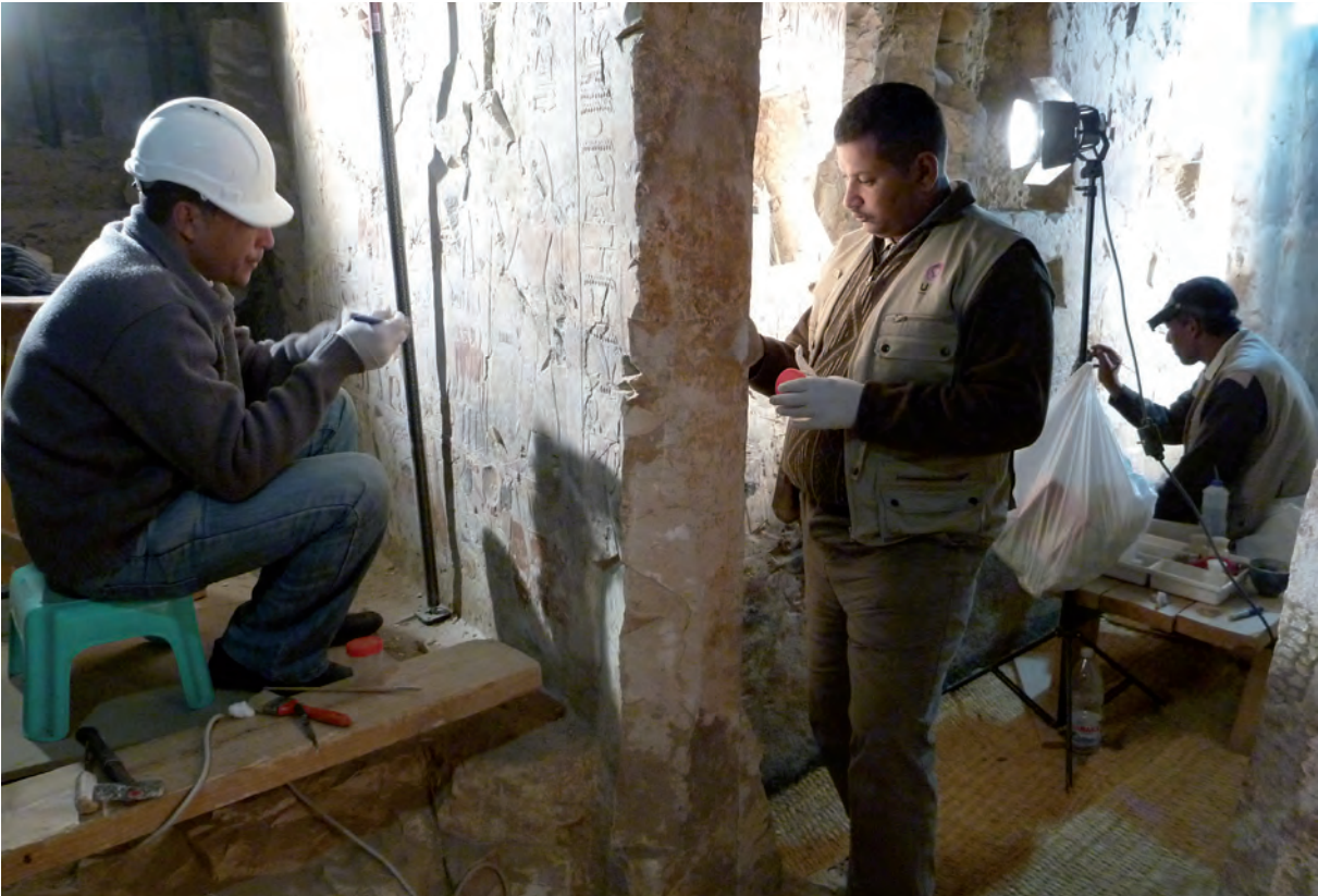
Figura 3: Limpieza y consolidación de las paredes del pasillo y de la sala más interna de la tumba-capilla de Djehuty.
