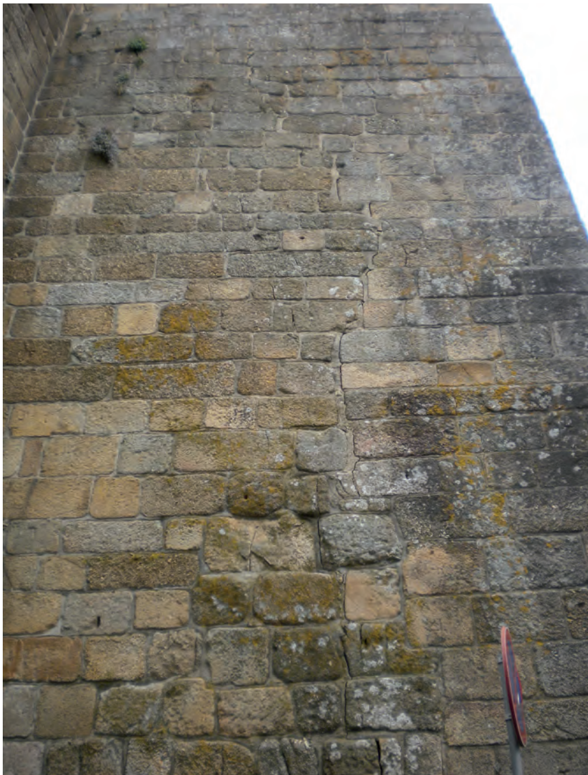
Figura 11: Ruina (UE 1001) de la fábrica UE 1000 en su extremo oriental y reconstrucción (UE 1009). Fotografía: M.ª Á. Utrero Agudo.
