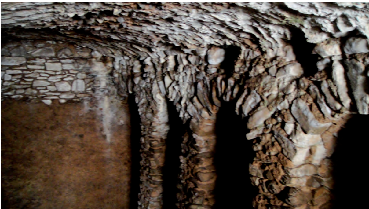
Figura 7: Vista de los sillares y arcos del recinto subterráneo o posible cárcel del palacio de Sarka.
