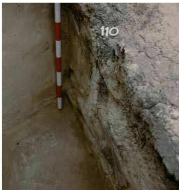
Figura 32. Detalle del tapial del muro de la habitación republicana (U.E. 110), con la capa blanquecina de regularización exterior.
