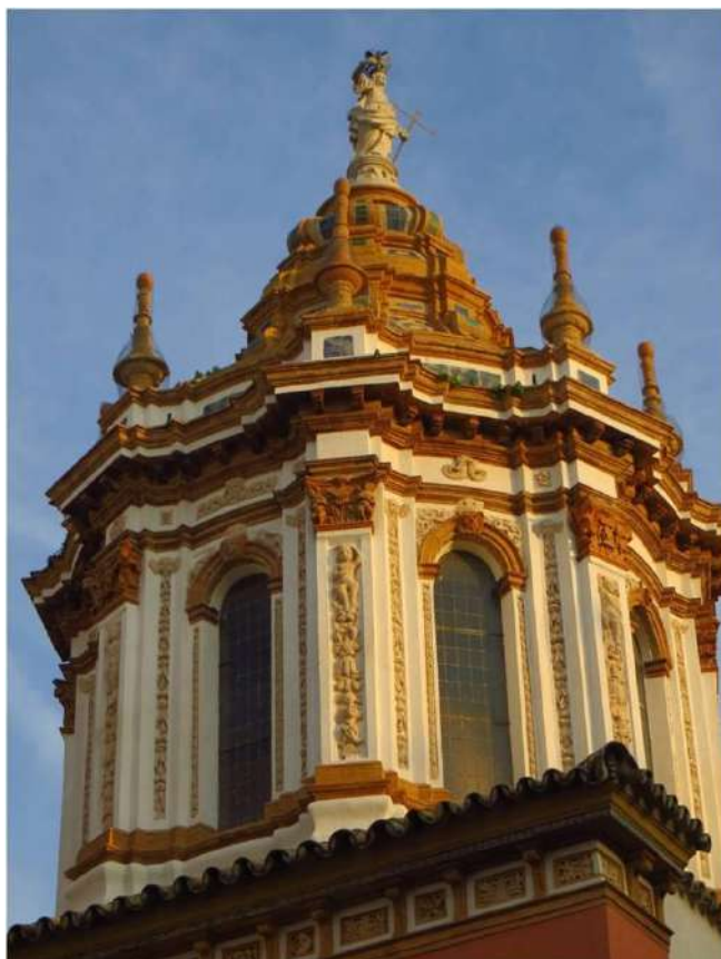
Figura 4. Linterna de la Capilla sacramental de Santa Catalina
