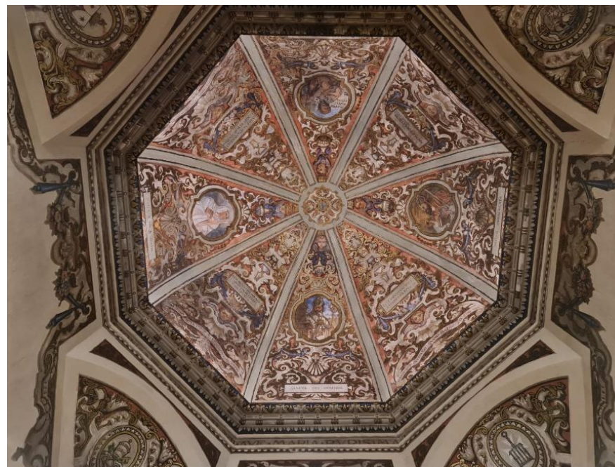
Figura 3. Bóveda ochavada sobre trompas, Capilla de la Soledad de San Lorenzo
