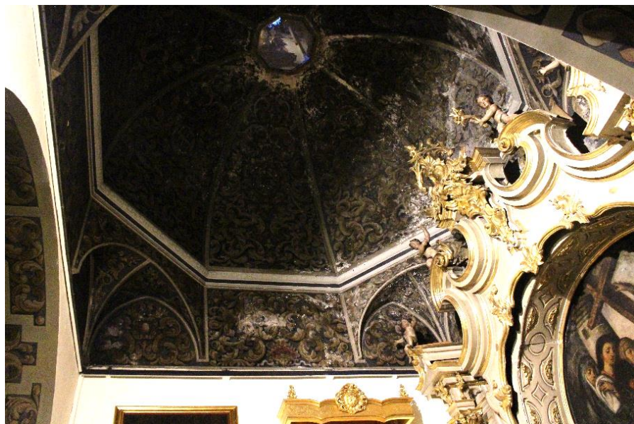
Figura 7. Bóveda ochavada sobre trompas de arista, Capilla del Cristo de las Fatigas
