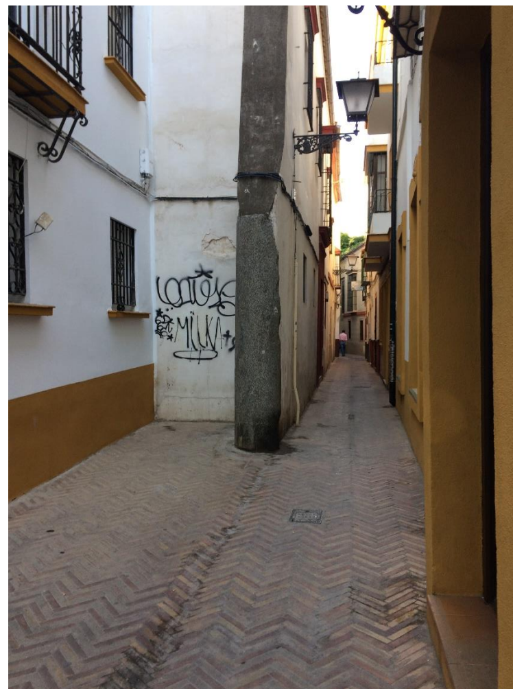
Figura 4. Grueso muro y fuste de columna de granito
