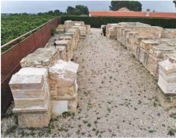
Vista este de la nave central de Pla de Nadal en la actualidad. Foto: Albert Vicent Ribera
