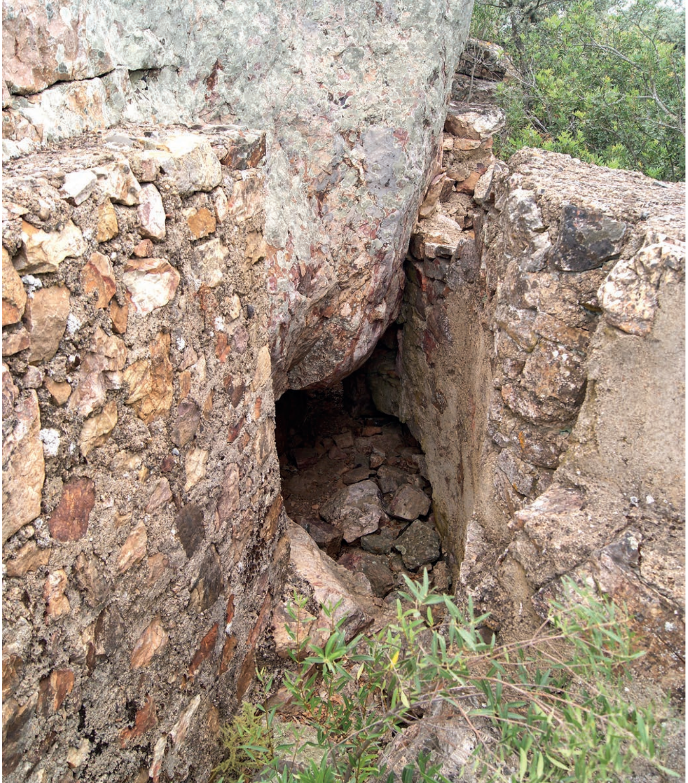
Trinchera de comunicación que aprovecha lo abrupto del terreno.
