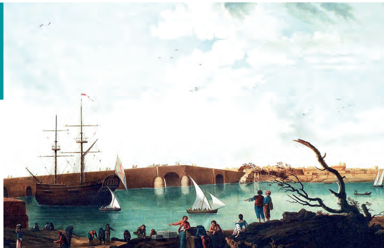
Puente de Suazo. Palacio de la Zarzuela.
