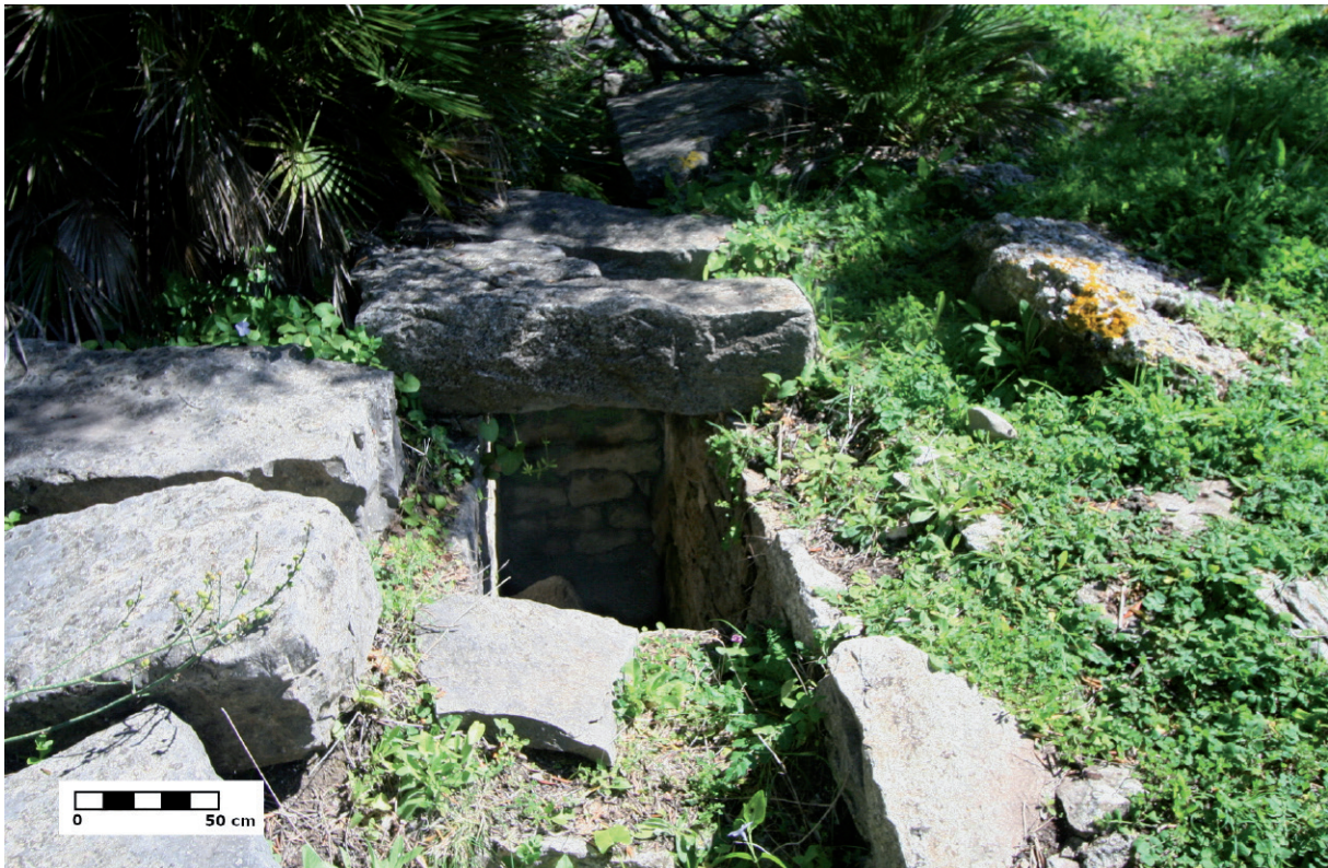
Figura 17. Restos conservados de la existencia de un alcantarillado o sistema de evacuación de aguas residuales.
