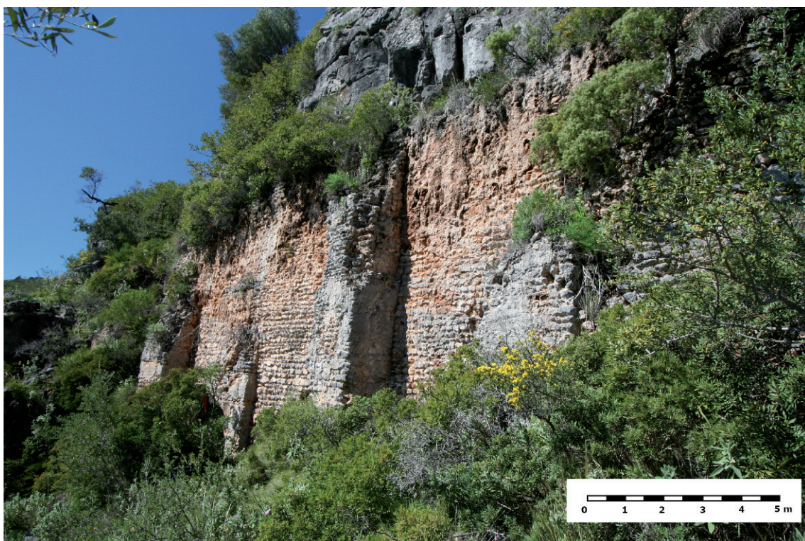
Figura 4. Paredón de sillarejo con contrafuertes para el sustento del specus adosado a la ladera.
