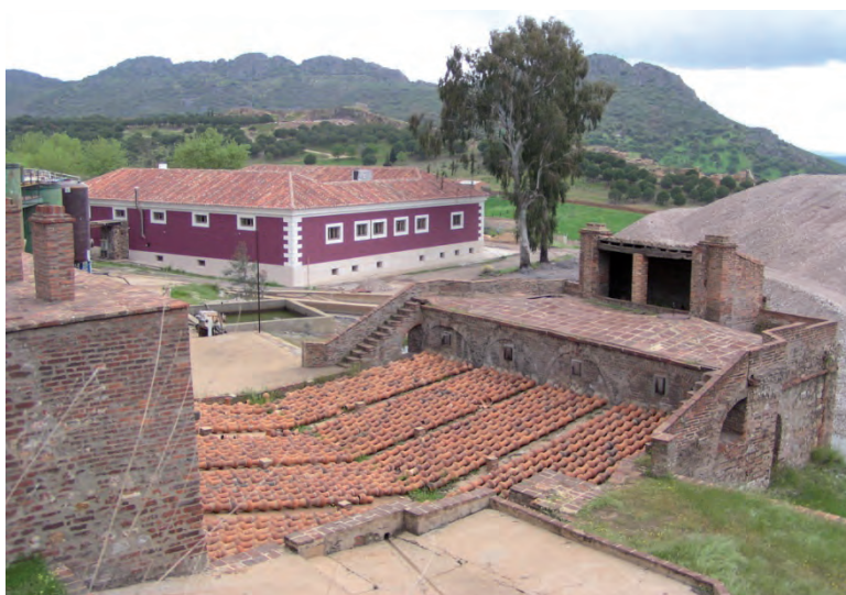
FIG. 3. Cerco de Buitrones: horno de aludeles y almacén de mercurio. 2009
