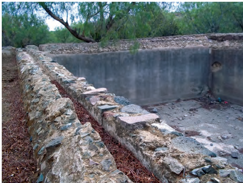
FIG. 5. Sistema de hidráulico Siglo XVI para llevar agua por precipitación para el sistema de Beneficio de patio empleado en la Hacienda del Buen Suceso. Foto: Guadalupe Dávalos Macías
